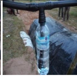
ภาพที่ 9 ประกอบสายส่งก๊าซและขวดปรับแรงดัน
